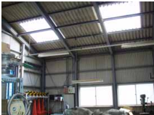
倉庫天井を 一部透明化。日中の蛍光灯が不要になり、節電効果大。
