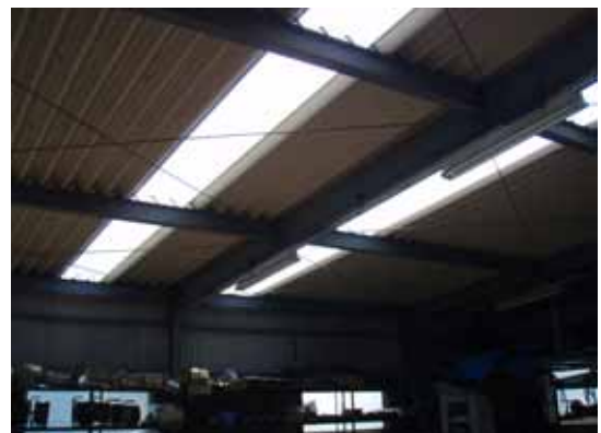
倉庫天井を 一部透明化。日中の蛍光灯が不要になり、節電効果大。
